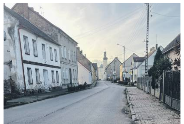
W ramach inwestycji planowany jest remont ul. 1 Maja – drogi dojazdowej do wiazowskiego rynku
