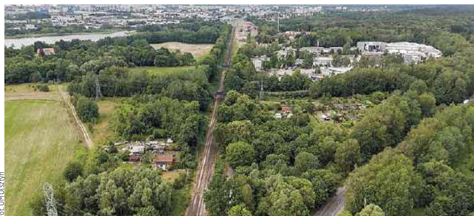
Budowa tunelu umożliwi dojazd z ul. Lubelskiej na Zatorze
