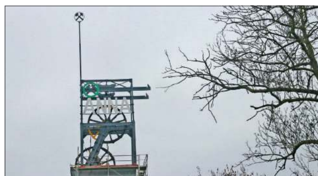
Na terenie po kopalni Anna trwa m.in. montaż podestów na szybie Jan, który stanie się wieżą widokową
