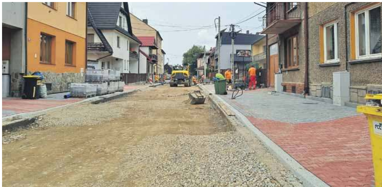
Ulica Nadwodnia już częściowo odzyskała chodniki.
