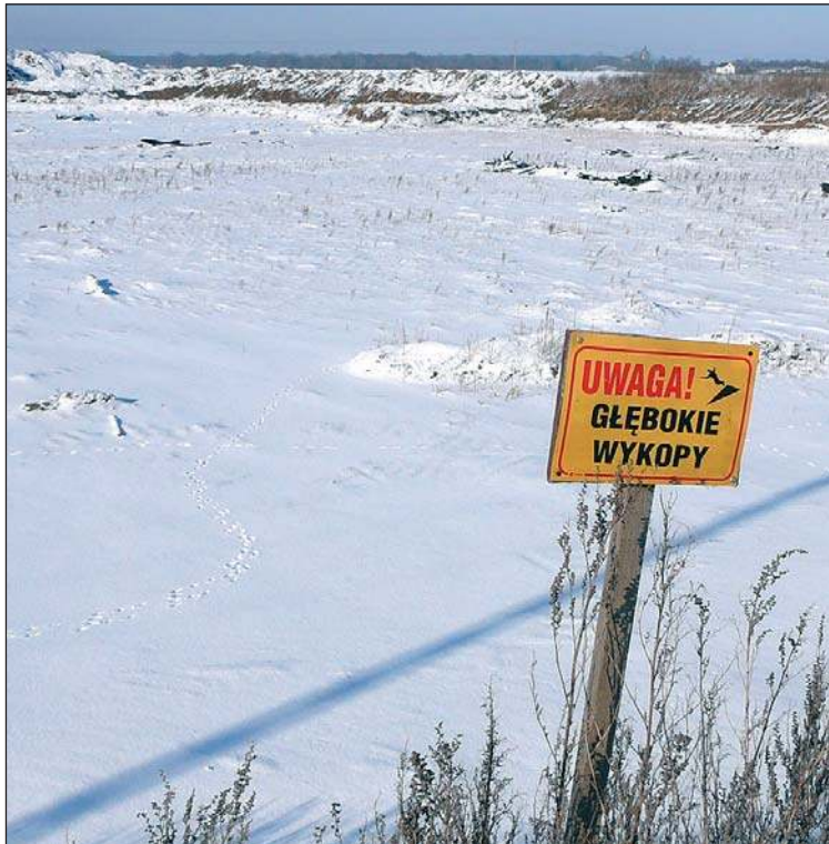
Po wydobywaniu kruszywa w Grabinach powstały głębokie wykopy. Prywatna firma chciała tu prawdopodobnie zbudować stawy.
