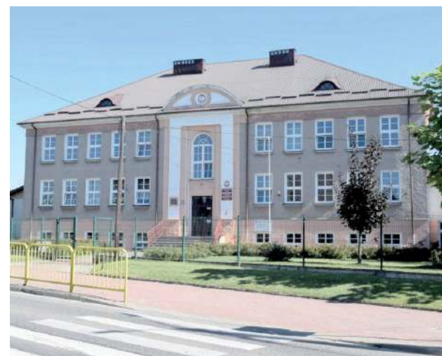
Wkrótce w szkole we Frampolu pojawią się rusztowania i ekipy budowlane
