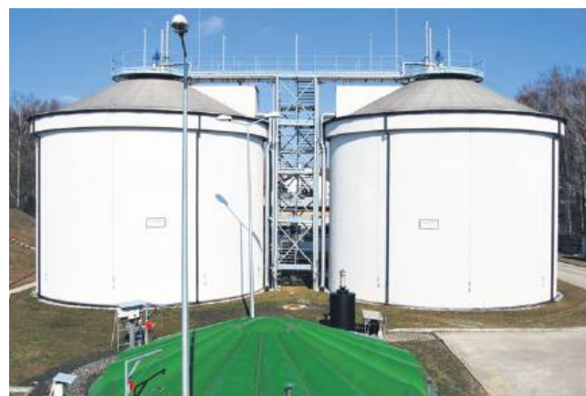
Przebudowa oczyszczalni to koszt ponad 58 mln zł.
