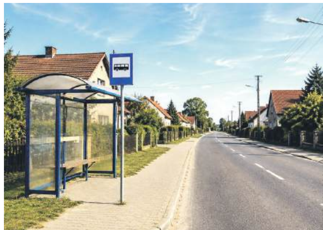
FOT. ZDJĘCIE POGŁĄDOWE
