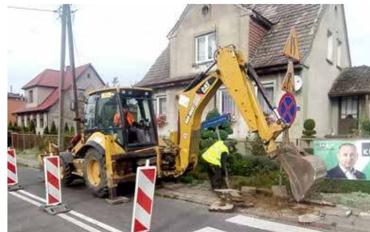
Firma Dro-Most rozpoczęła prace w środę od strony skrzyżowania z ul. Armii Krajowej
