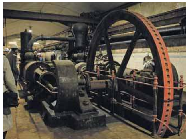
Do dziś przetrwała infrastruktura wodociągowa, czyli rurociągi w szybie Staszic, szybie Maszynowym oraz Sztolni Głębokiej Fryderyk. Istnieją wykute 50 metrów pod ziemią hale dla maszyn z silnikami na parę sprężoną, napędzającymi pompy tłoczące wodę. Zachowała się jedna maszyna produkcji Maschinenbauanstalt des Kgl. Huttenamtes z Gliwic, zainstalowana w 1903 roku i zmodernizowana w 1921 roku
