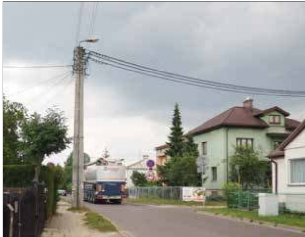
Część słupów na terenie miasta zagraża bezpieczeństwu mieszkańców, gdyż znajduje się w fatalnym stanie technicznym
