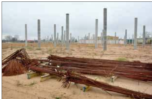
Od października 2018 plac budowy świeci pustkami. Naczelny Sąd Administracyjny wydał ostateczny wyrok umożliwiający powrót do budowy Centrum Handlowego w Białej Podlaskiej
