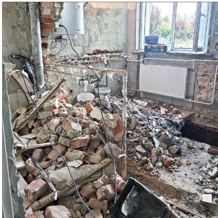
Szkoła w Żyrakowie to jedna z tych, gdzie trwają remonty.
