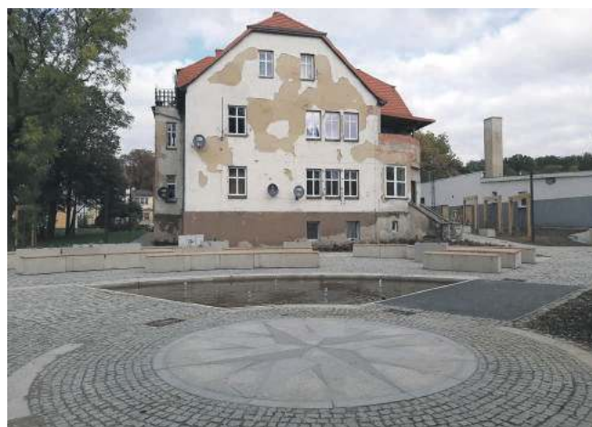
Fontanna, nasadzenia roślin, gwiazda z kostki granitowej, podium. Przestrzeń miejską z nowymi elementami zaktóca widok elewacji budynku, z której odpada tynk
