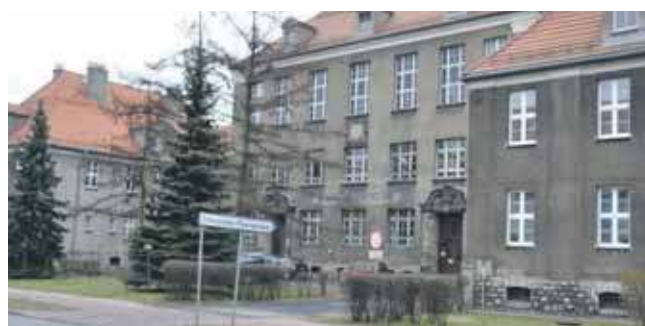
1,2 mln zł będzie kosztować remont pracowni do nauki zawodu w „Chemiku”
