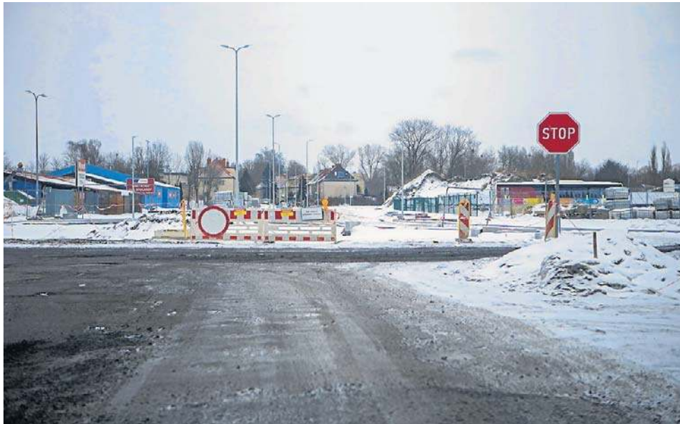
Budowa ringu w zimowej odsłonie. Przebieg prac spowolnił, na co miały wpływ mrozy i opady śniegu
