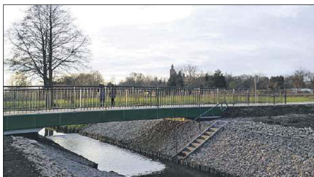
Miasto wzbogaciło się o nową infrastrukturę drogową, która stanowi alternatywną przeprawę przez rzekę Toczna
