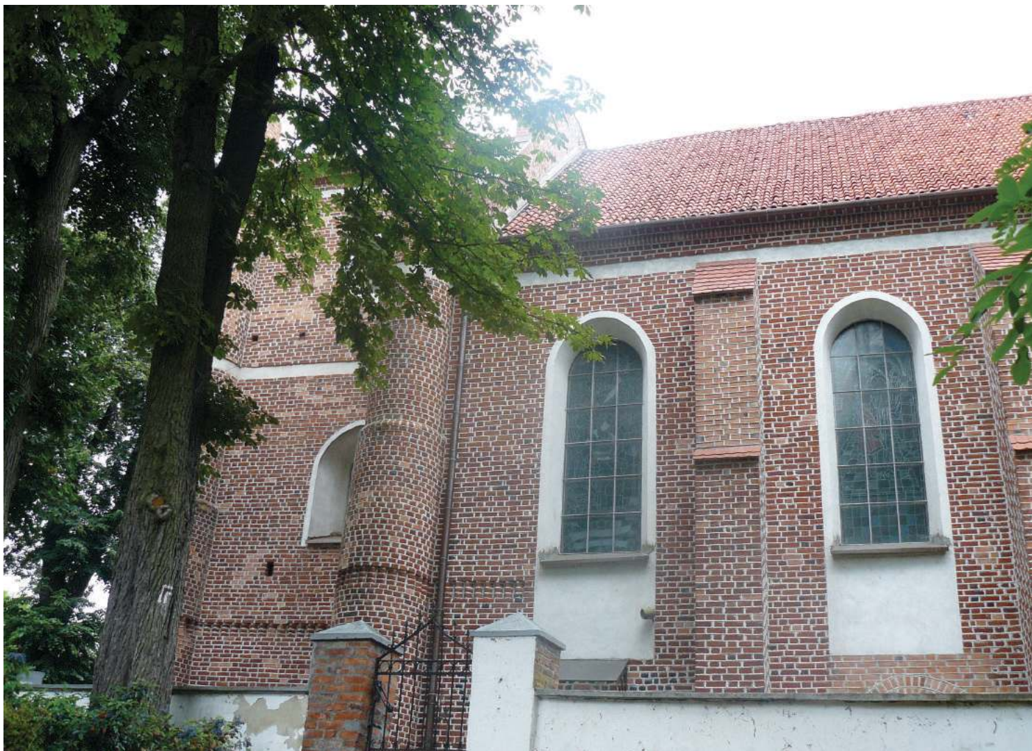
Odnowiona elewacja gotyckiego kościoła z Serocka
