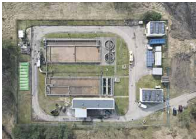
Podczas słonecznych dni energia z instalacji będzie w całości zaspokajać potrzeby Miejskiej Oczyszczalni Ścieków
