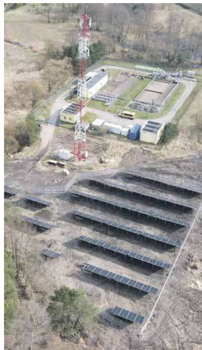
Miasto jest właścicielem gruntu przy oczyszczalni ścieków, co umożliwiło usytuowanie instalacji fotowoltaicznej w bezpośrednim sąsiedztwie odbiorcy energii elektrycznej
