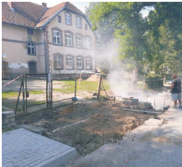
Kolejny etap budowy chodnika w Zarzycy został wykonany przez lokalną firmę, a koszt budowy wyniósł blisko 30 tys. zł. Foto: UG w Kondratowicach
