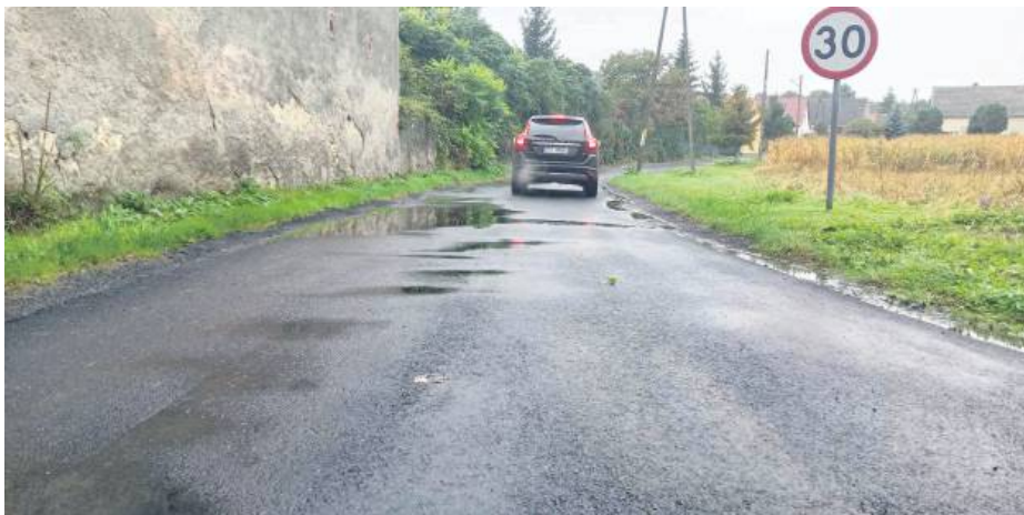
W Krzywiniu na ponad 80-metrowym odcinku bocznej drogi położono nowy dywanik asfaltowy
