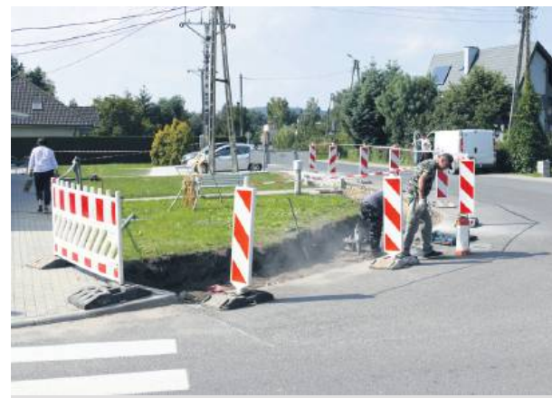
W ramach inwestycji wykonano rozbiórkę starej nawierzchni, budowę nowego ciągu pieszego i pochylni dla osób niepełnosprawnych
