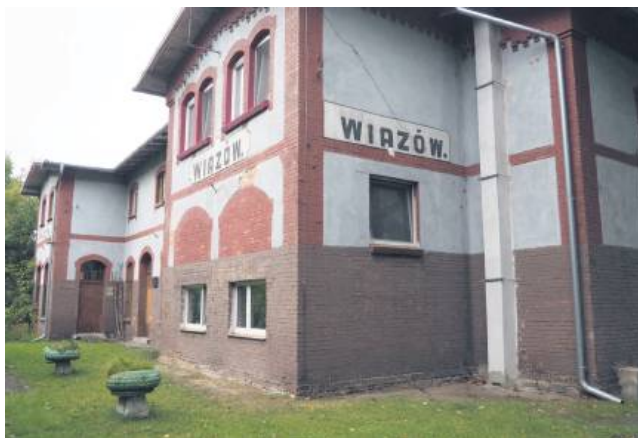
Tak dziś wygląda budynek stacyjny PKP, w którym mieszkają lokatorzy
