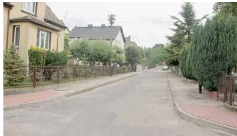
Po wyłonieniu wykonawcy przebudowana zostanie nawierzchnia ulicy K. Wielkiego
