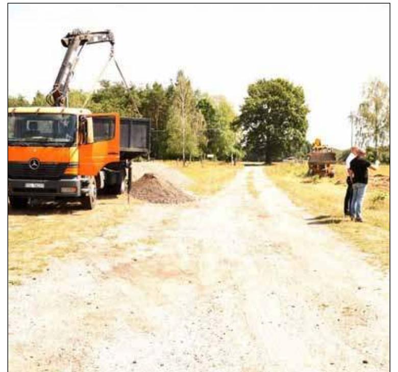
Prace budowlano-ziemne w Czermnicy ruszyły w czwartek. Fot. UM Nowogard
