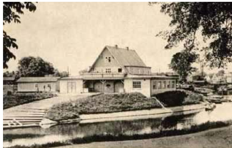
Nowy budynek przystani zbudowano w 1934 roku
