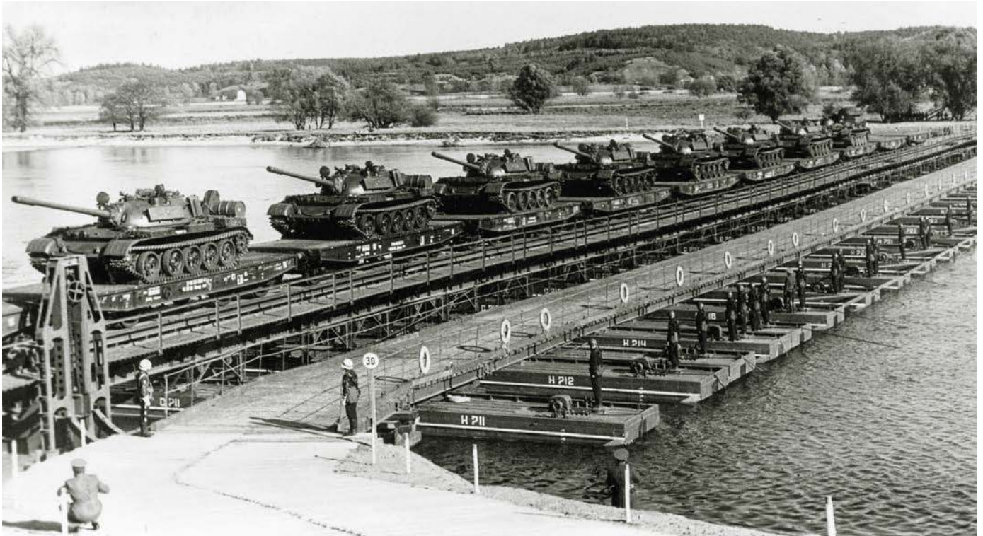
▲ Zdjęcie wykonane podczas sojusznicznych ćwiczeń „Bariera 79” – z udziałem jednostek PGWR w Polsce. Składany most kolejowy na Nysie Łużyckiej posłużył do przerzutu czołgów transportem kolejowym.
