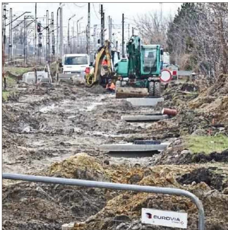
Wśród inwestycji, które kontynuowane będą w tym roku jest m.in. przebudowa ul. Mościckiego i Metalowców.
