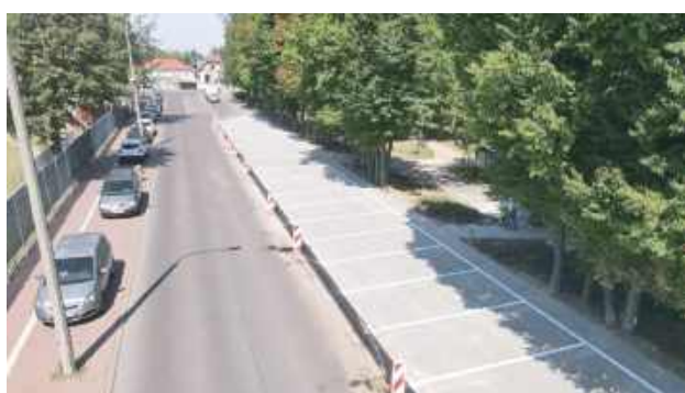
W ramach inwestycji rozebrano zniszczoną nawierzchnię asfaltową
