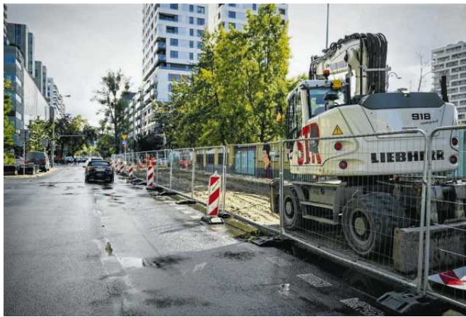
• Remont ul. Grzybowskiej zaczął się od skrzyżowania z Karolkową i Siedmiogrodzką FOT. URZĄD M.ST. WARSZAWY
