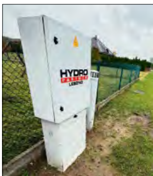
Przepompownię ścieków zmodernizowano m.in. w Kamieniu Śląskim.
