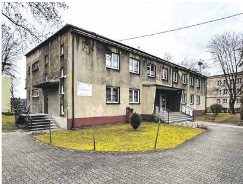
Termomodernizacja poprawi także estetykę budynków przedszkolnych
