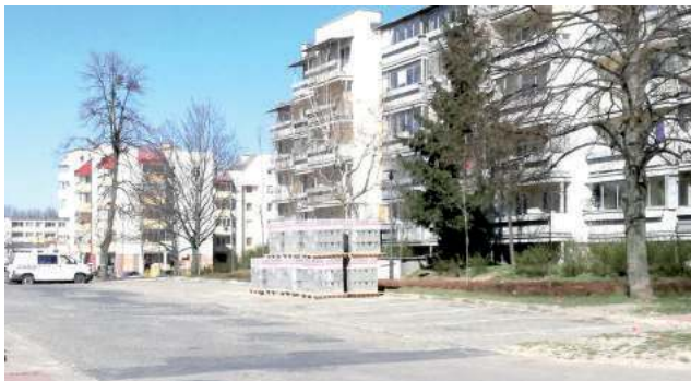
Zapelniony zawsze niemal do ostatniego miejsca parking opustoszał. Zamiast aut stały palety z kostką brukową, która już wkrótce pokryje cały teren
