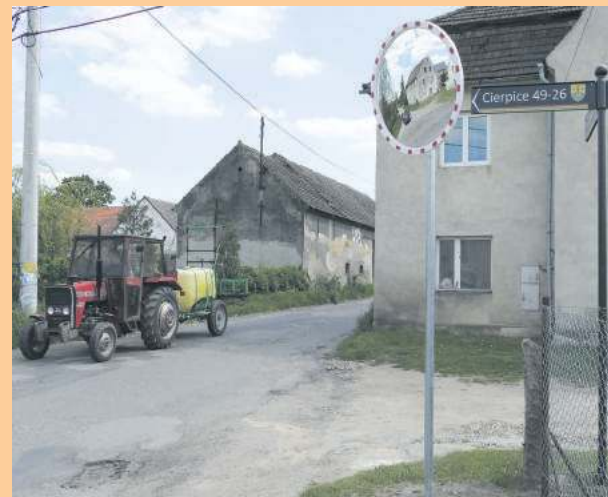
Przy głównej drodze w Cierpicach pracownicy Powiatowego Zarządu Dróg w Strzelinie zamontowali lustro
