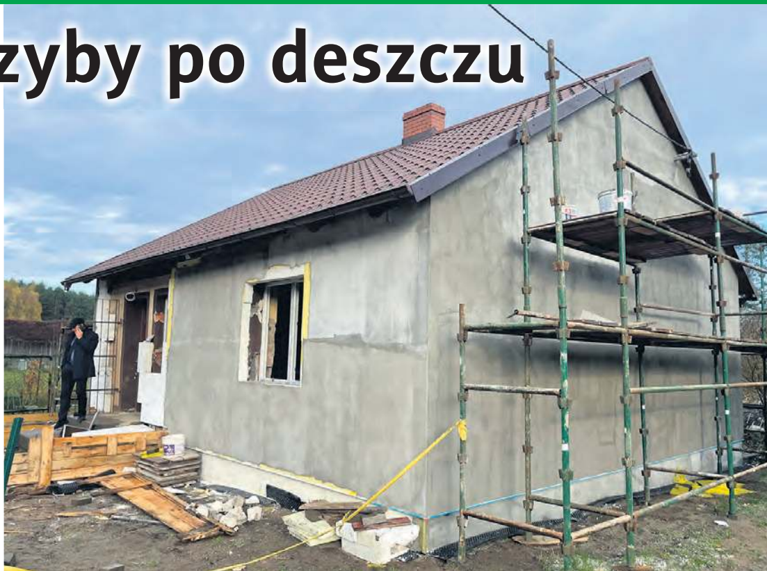
Zaawansowane prace trwają w Byłyczku.
