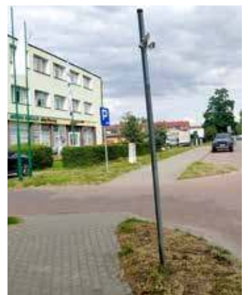
W tym miejscu powinien znajdować się brakujący element infrastruktury drogowej
