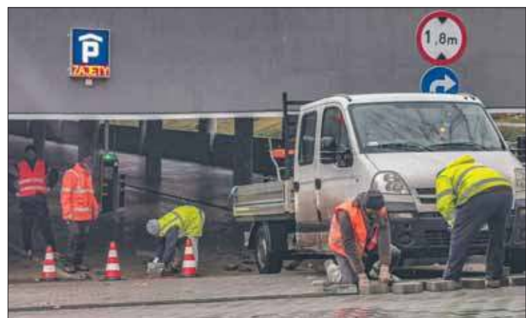
Na parkingu trwają kolejne prace modernizacyjne
