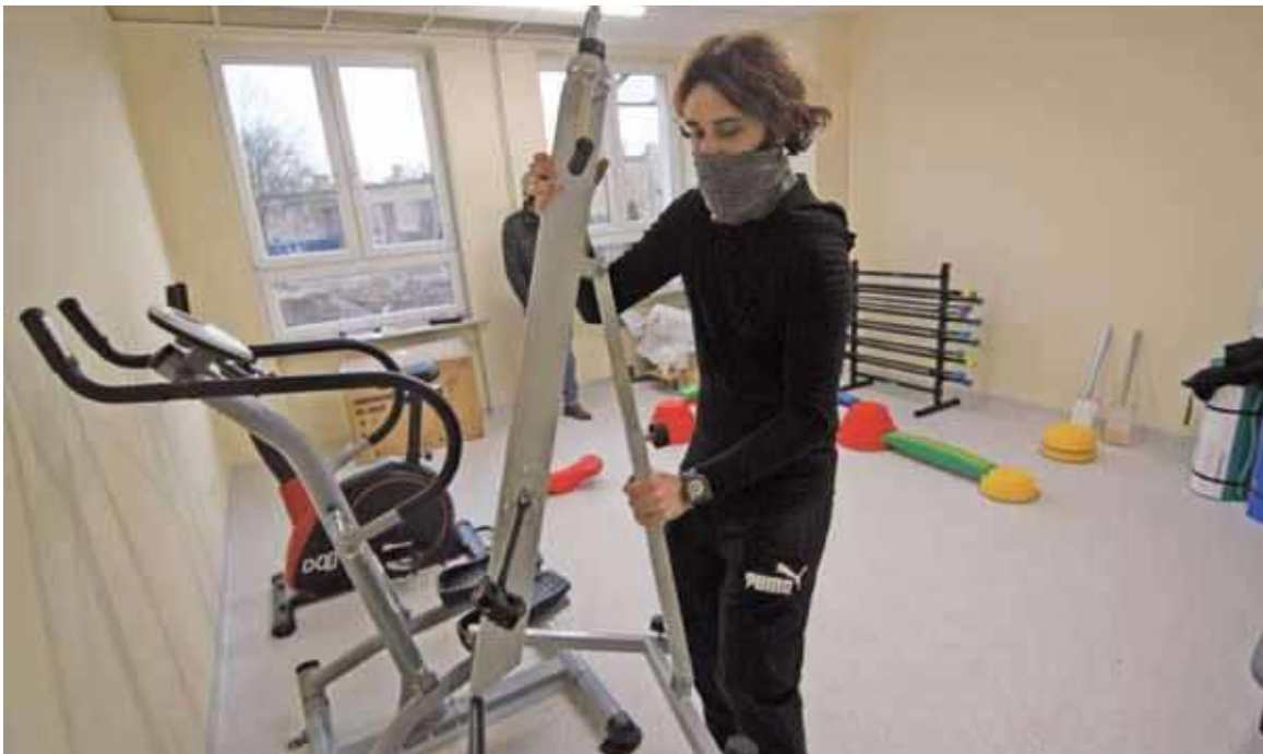
W budynku prace idą pełną parą, w jednej z sal trwa montaż sprzętu do zajęć ruchowych
