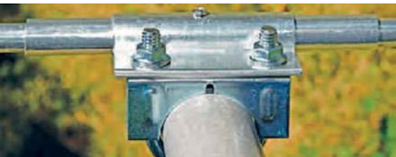
Fot. 2. Montaż elementów do nośnika
