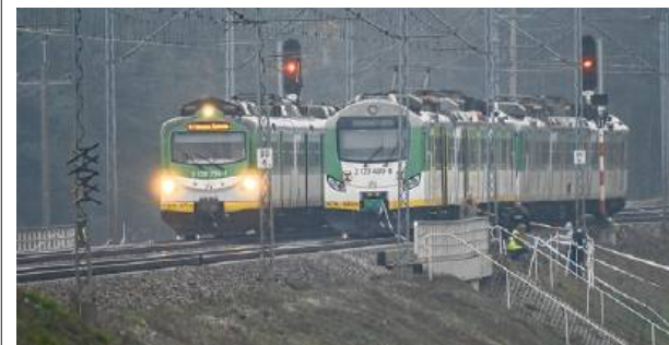
Oględziny przeprowadzone przez policję wykazały poważne uszkodzenie fragmentu toru
