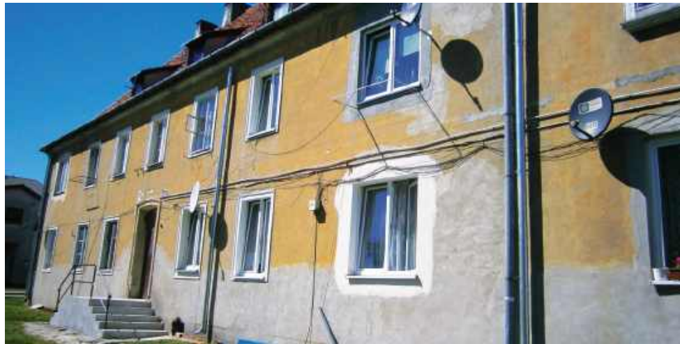
Pozyskane pieniądze pozwolą na wyremontowanie 16 lokali mieszkalnych przy Traugutta 26 i Szkolnej 9
