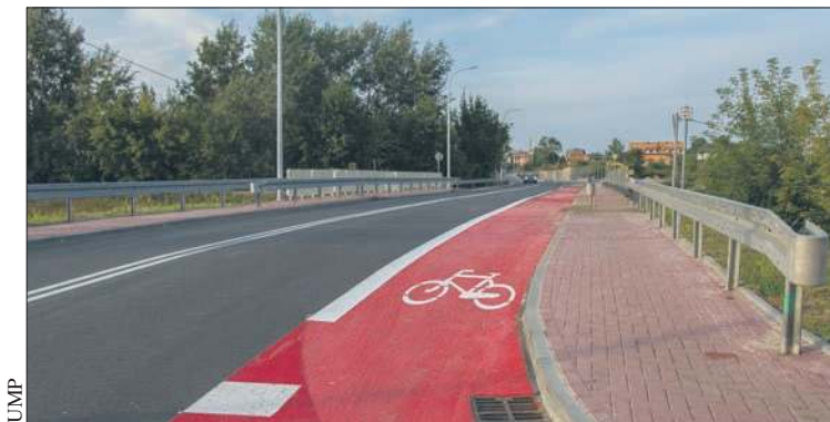
Nowa nawierzchnia, ścieżka rowerowa, chodnik, oświetlenie. Tak po przebudowie wygląda ulica Pocztowa
