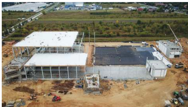
Budowa na obecnym etapie
