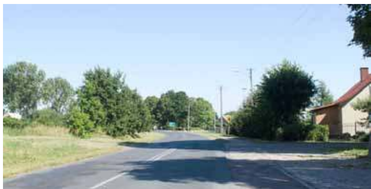
Gmina Stara Dąbrowa uzyskała dofinansowanie z Powiatu Stargardzkiego i Rządowego Funduszu Dróg na przebudowę drogi w Starej Dąbrowie
