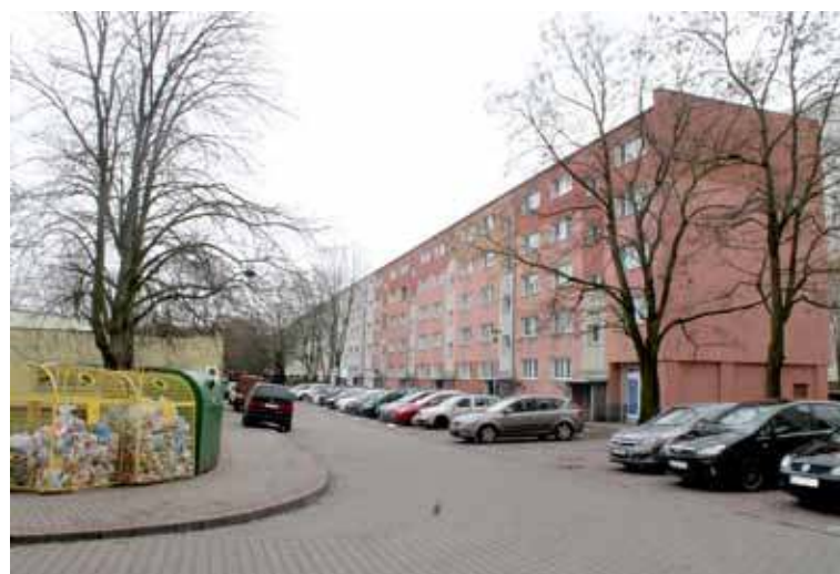
Nie ma też odpowiedniego dostępu przeciwpożarowego do budynku A 10-13, gdyż droga nie jest zakończona placem manewrowym
