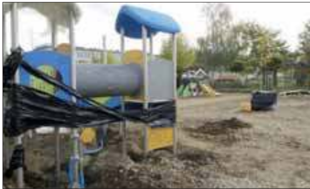
Budowa placu zabaw na plantach zmierza szczęśliwego końca
