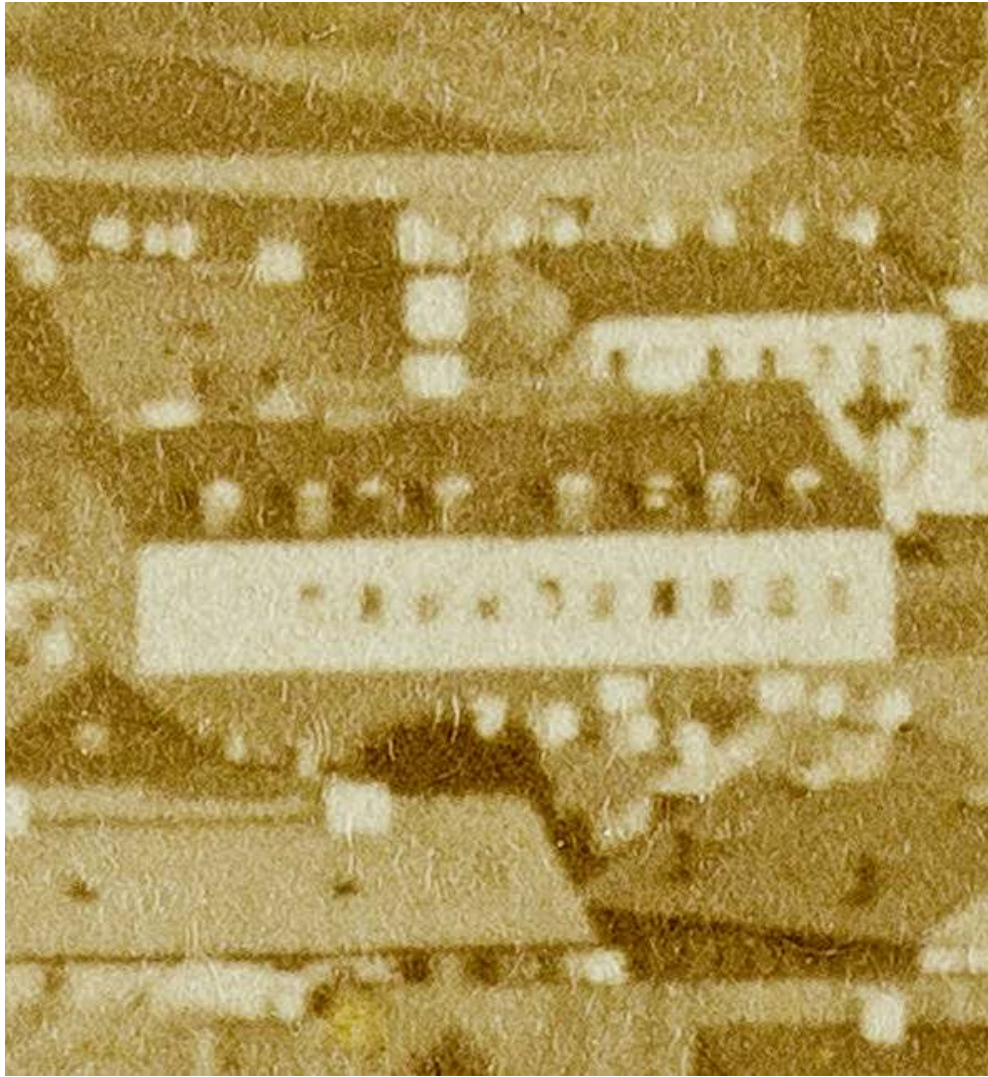
Ten sam budynek w centralnej części zdjęcia z 1873 r. | fot. Konrad Brandel – Zbiory Muzeum Narodowego w Warszawie
