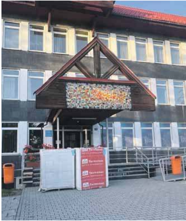
Dwie palety pustaków miały posłużyć do zamurowania wejścia do budynku.
