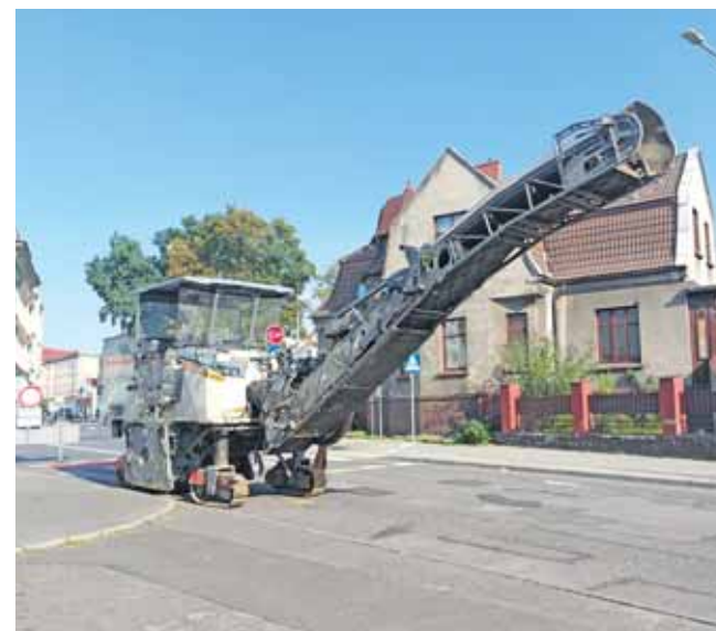
Na pierwszy ogień poszło frezowanie starej nawierzchni
