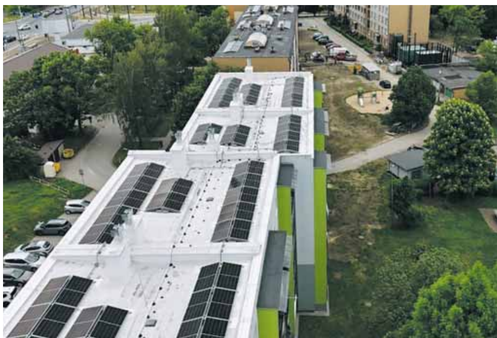
Inwestycje warte 32 mln zł prowadzi Przedsiębiorstwo Energetyki Ciepłej w Bytomiu
