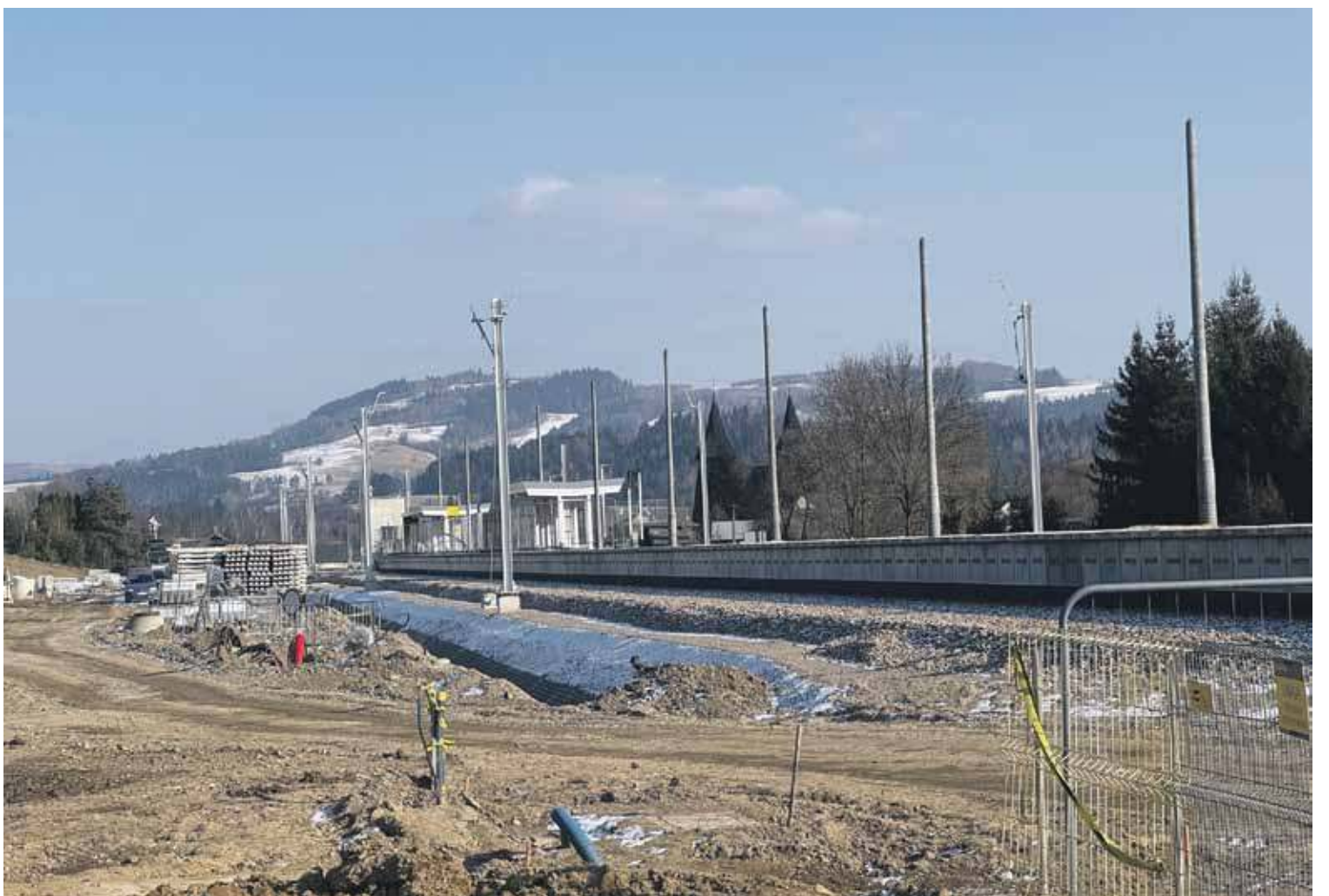
Budowa linii kolejowej w Zarytem komplikuje kanalizację tej rabczańskiej dzielnicy.
