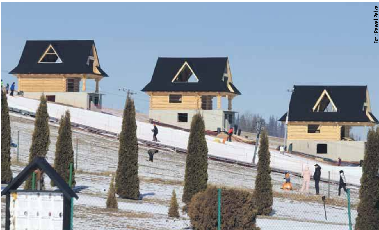
Investor odwołał się od postanowienia o wstrzymaniu robót budowlanych. Tak „poidelka dla koni” wyglądały w poniedziałek.
