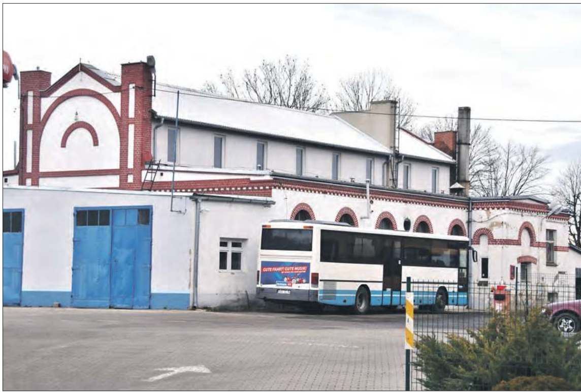
Budynek głównego warsztatu w 2022 r. Budowla nawiązywała do budownictwa sakralnego. Polscy badacze architektury taką inspirację dostrzegli również w przypadku byłej siłowni Froteksu.
