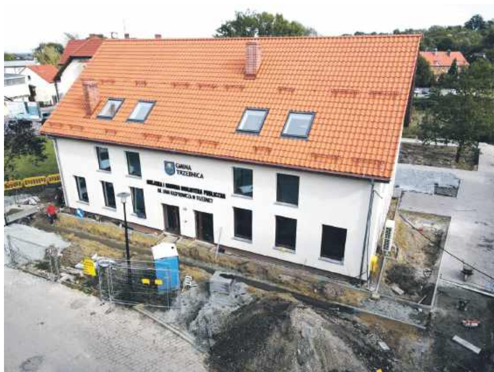
Jak widać, na dachu nie ma wjazdu, ani stopni. Są jedynie zabezpieczenia przed śniegiem
