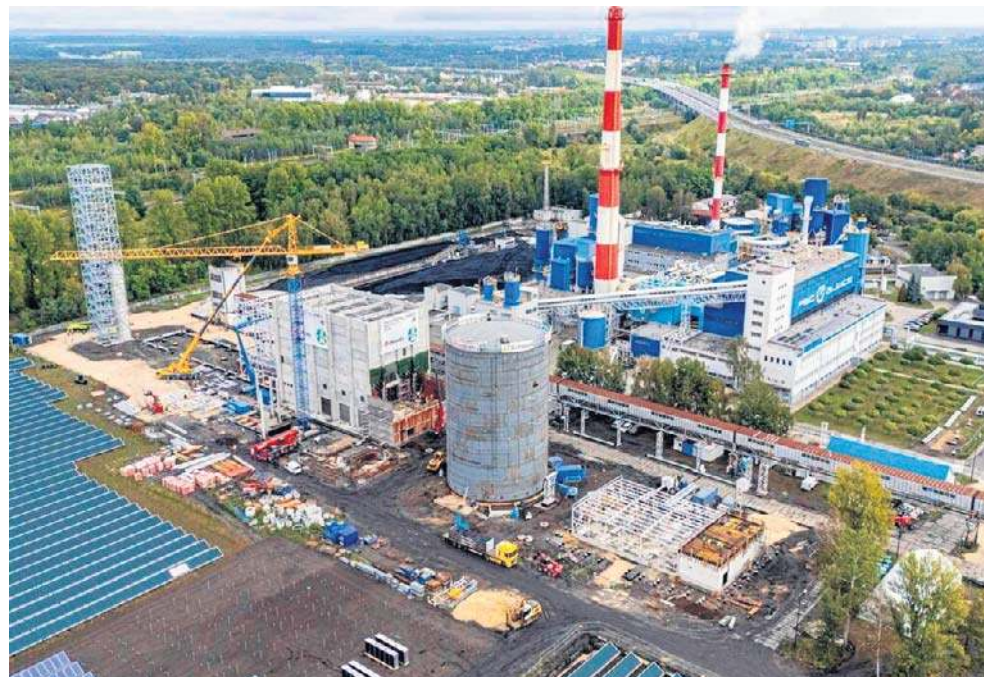
Na terenie budowy przy ul. Królewskiej Tamy symbolicznie zaznaczono kolejny etap
