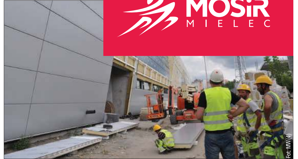
Robota wre, elewacja już powstaje!
