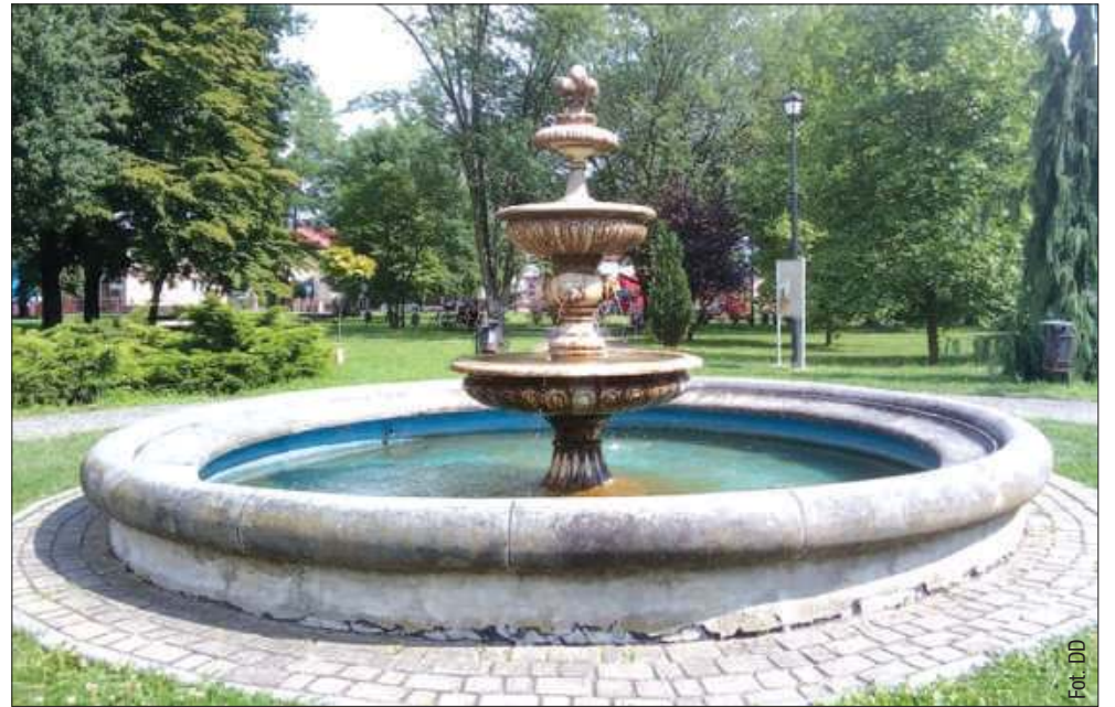
Trwają czynności w sprawie zdewastowania fontanny przy ulicy Legionów.
