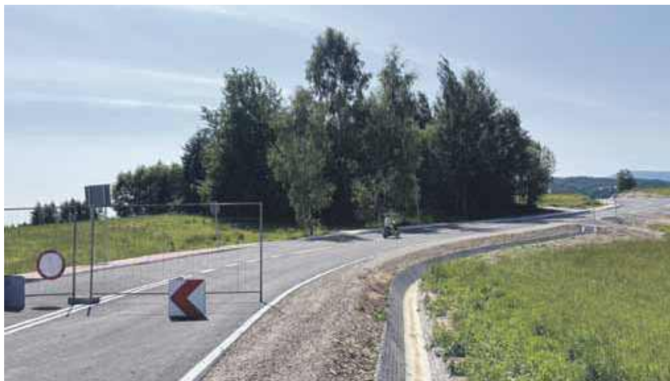
Piękny asfalt w miejscu dotychczasowej drogi gruntowej.
