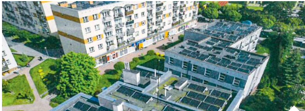
Przepisy wprowadzające prosumenta zbiorowego rozwiązują problem braku posiadania własnego dachu, na którym można zainstalować system fotowoltaiczny | fot. mat. pras./d
